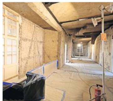
„Ergebnis einer Schadstoffsanierung“: Der Putz musste ab.
