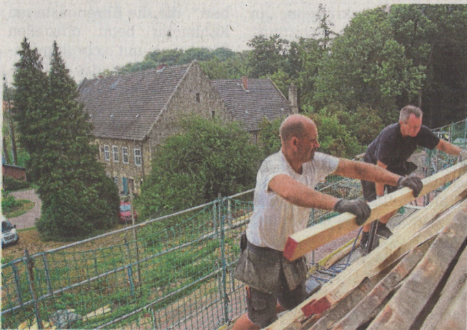
Es geht voran: Der Dachstuhl über dem Slaphus wird bereits saniert.
