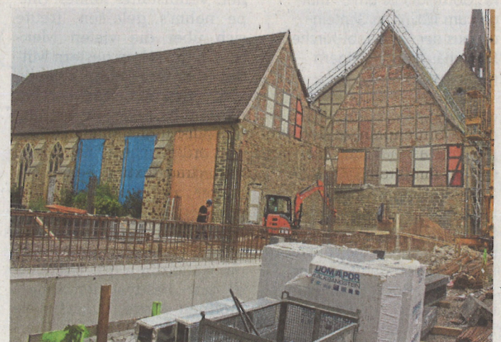
In Priors Garten beginnen die Bauarbeiten an der Bibliothek – beim Denkmalstag aber stehen alte Gebäudeteile im Mittelpunkt.
