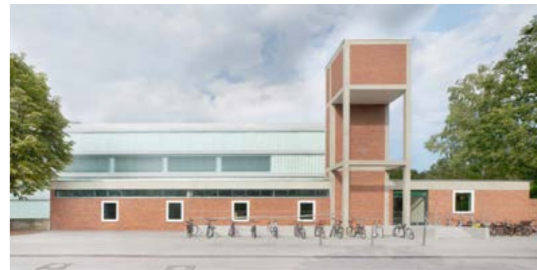
Eingangssituation Sporthalle Ostseite Denkmalgeschützter Bestand mit ehemaligem Schornstein als städtebaulicher „Landmarke“ und neue Dreifeld-Sporthalle
